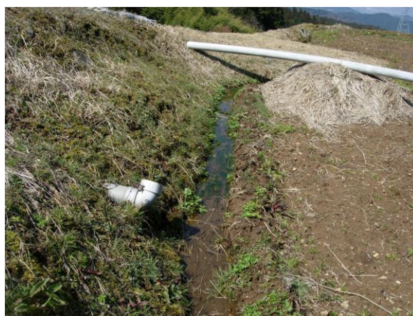
写真 2-(8)-2 素掘りの水路
