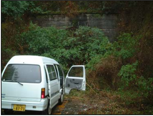
図17. トンネル入口
