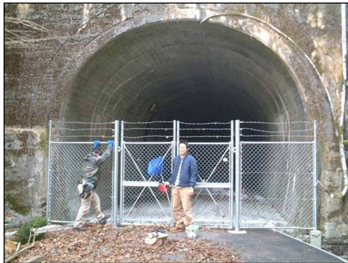
図 26. トンネル入口
