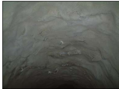
図 15. トンネル内壁
