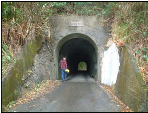
図 14. トンネル入口
