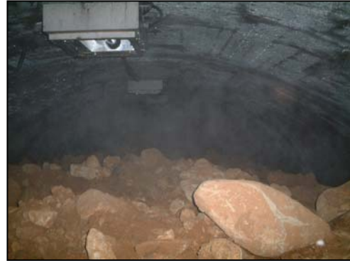
図18. トンネル内部の状況
