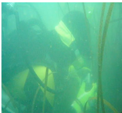
潜水調査風景
