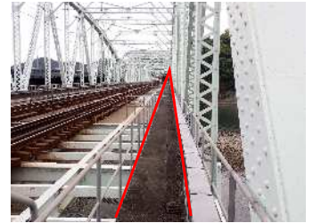
鉄道橋のアスファルト部分
