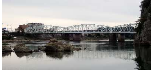
犬山橋:橋長223.15m, 幅員16mの鋼トラス橋
