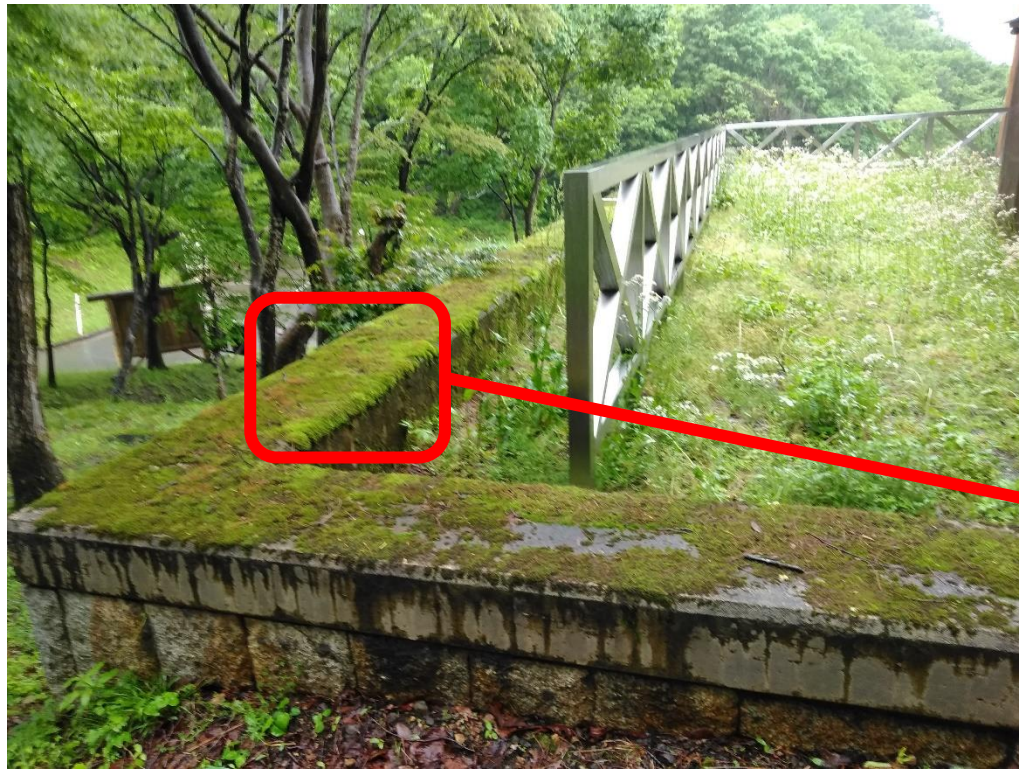
▲福井県自然保護センターの外壁部
