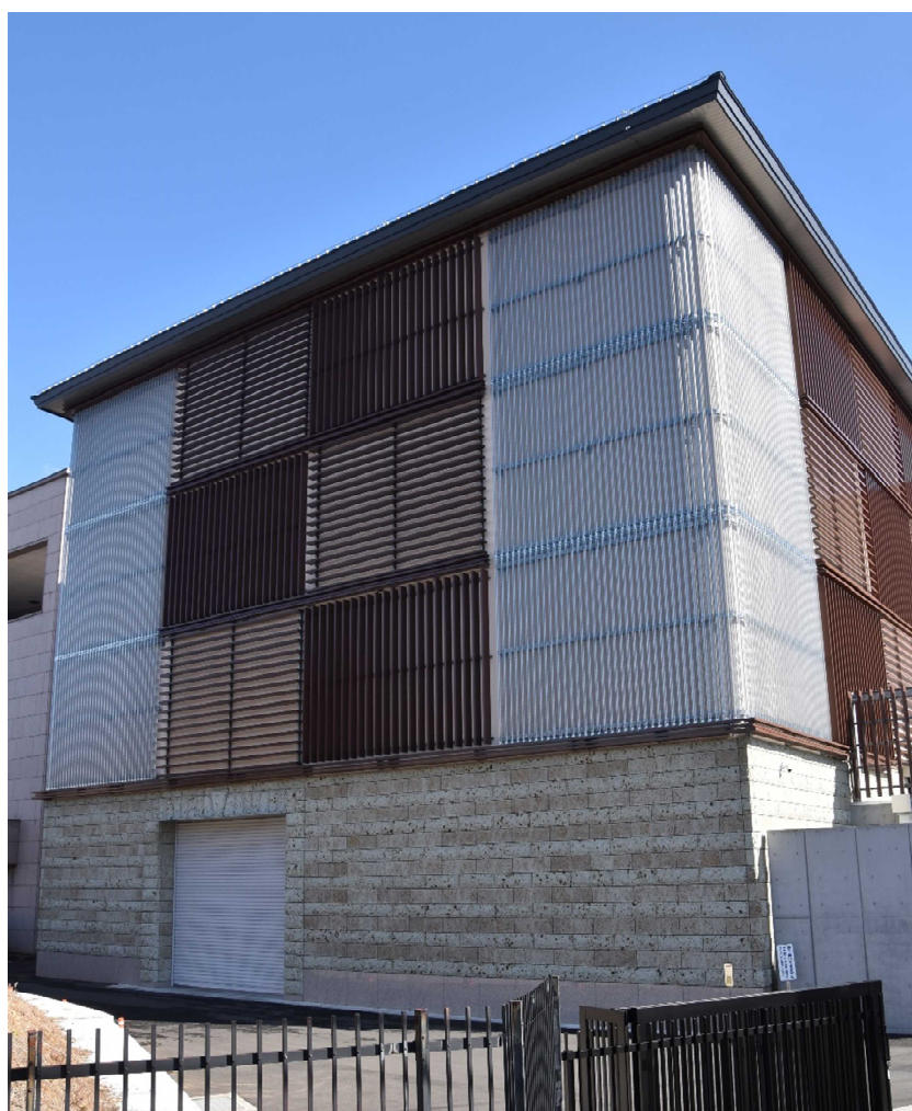
栃木県立博物館の新収蔵庫棟（令和2（2020）年3月完成）
