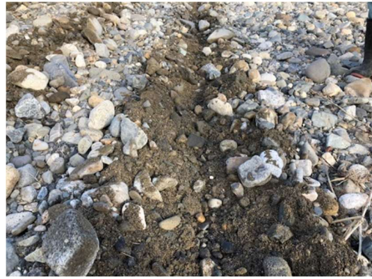
写真-3 施工後の近景 (2017年12月)
