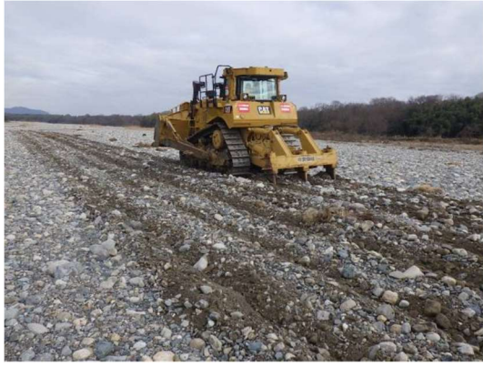
写真-2 試験施工の様子 (2017年12月)
