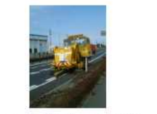
図8. 国土交通省による路肩清掃
