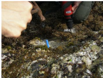
4. コーナーボルトを打ち付ける
