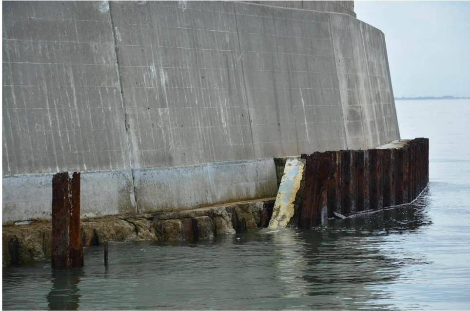
写真4-5-5 三池島、矢板が外れむき出しになったコンクリート壁
