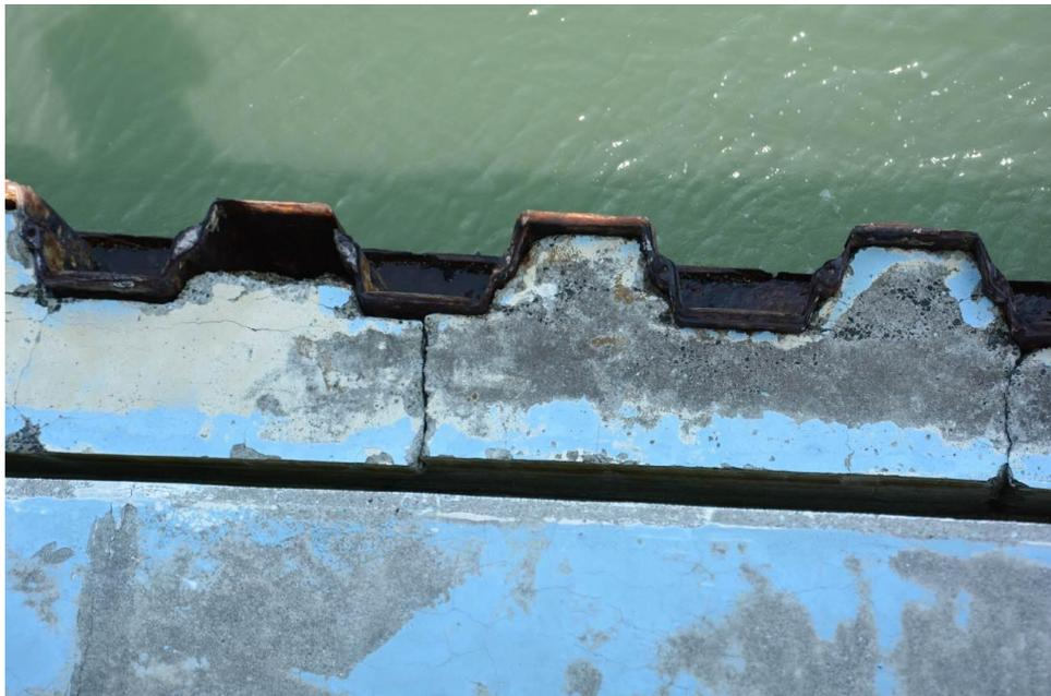
写真4-5-4 三池島、老朽化で傷んだ外壁（2018年6月2日）
