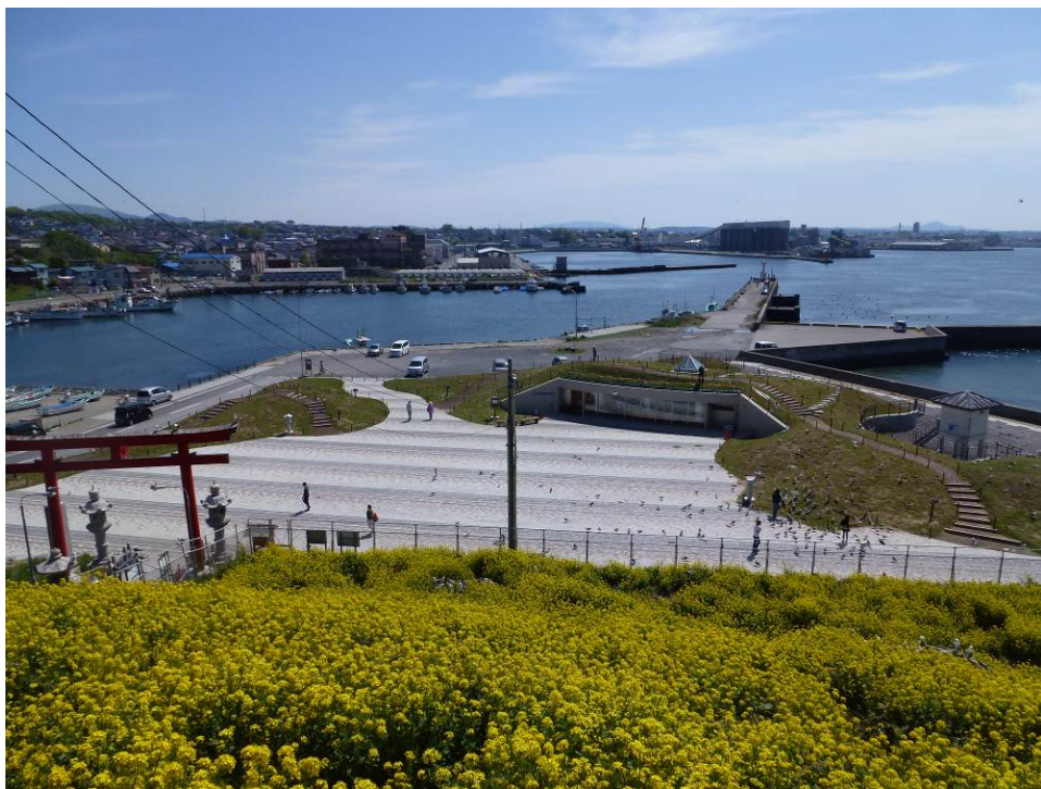
写真４－３－３ 燕島下の無料休憩所（中央）と新たに整備された芝生地 と遊歩道（2016年5月14日）
