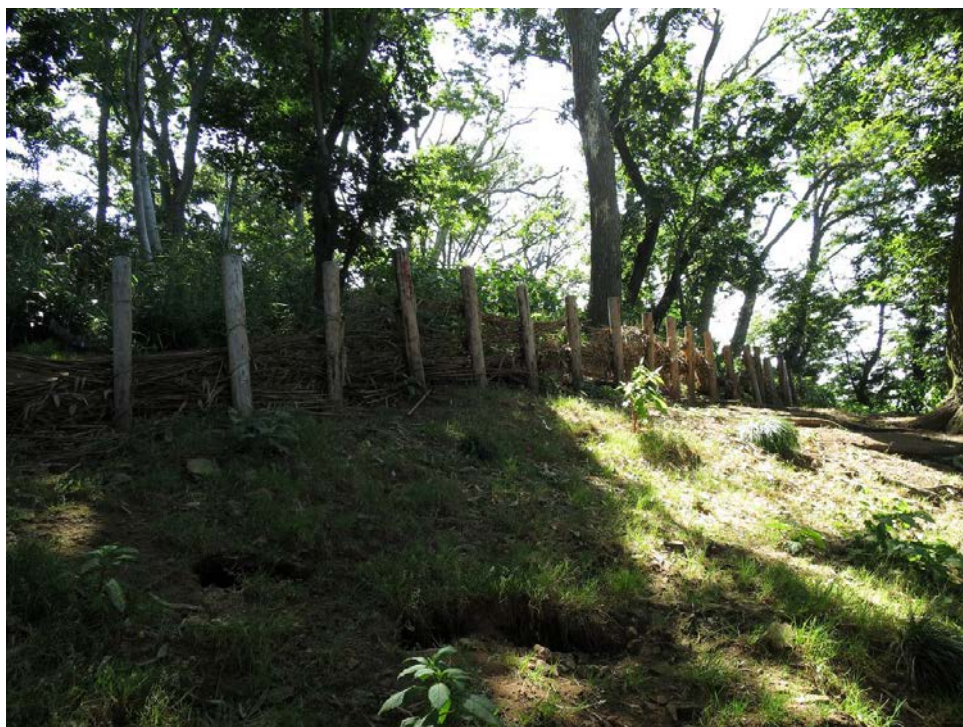
写真4-4-9 2016年3月に新設された土留め、支柱を立てヤダケで 土壌流出を止めている（2016年8月8日）
