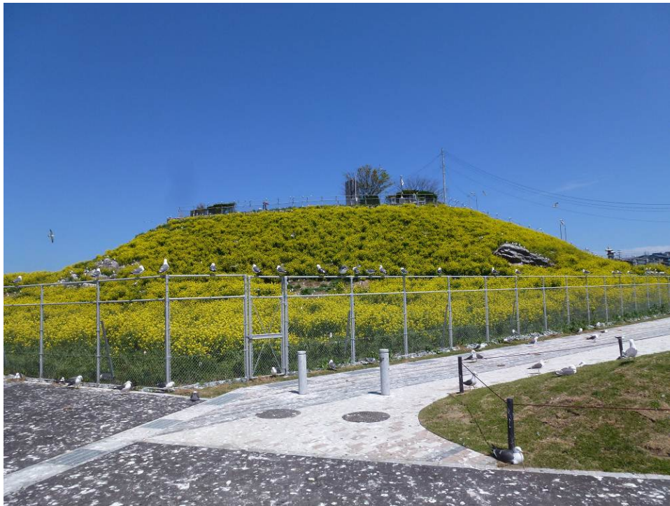
写真４－３－２ 燕島のウミネコ繁殖地と駐車場を隔てる金網フェンス (2016年5月14日)
