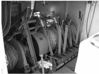
1. ウインチ (機材を上下運搬する)
