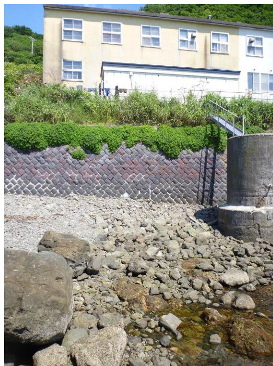
調査起点 (グレーペイントの縦線)
