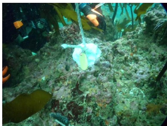
新たに設置したアイプレート
