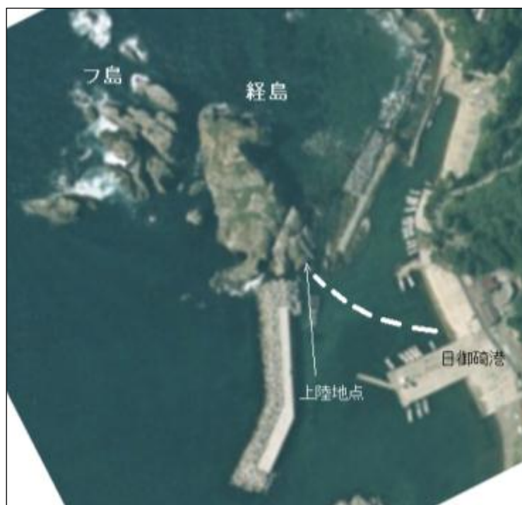
図 4－7－3 経島周辺の空中写真（海上保安庁の空中写真を加工）
