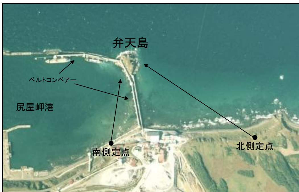
図 4－2－2 弁天島と観察定点（1993 年 10 月 19 日撮影、海上保安庁空中写真閲覧サービスを利用）
