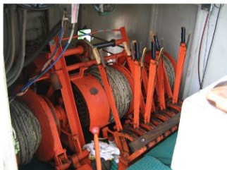
1. ウインチ (機材を上下運搬する)
