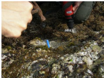
4. コーナーボルトを打ち付ける
