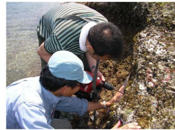
3. ハンマードリルで岩礁を穿孔する
