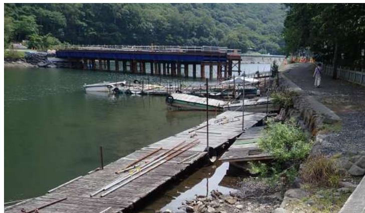
改修工事中の啄木鳥橋
