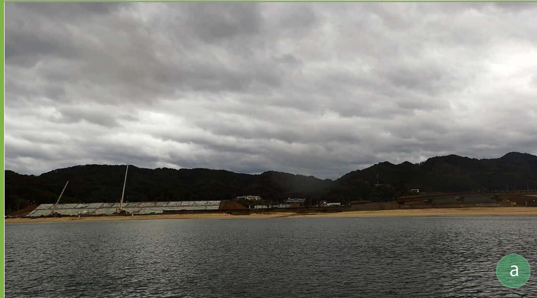
▲船越湾（吉里吉里）の調査地点。海側より陸側を望む。海岸では防潮堤の工事が進んでいます。
