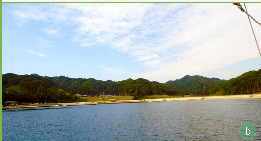
▲ 大槌湾（根浜）の調査地点。海上より陸側を望む。護岸工事が終わり、工事に伴う陸水の流入が止まりました。
