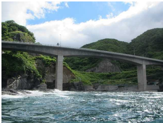
周辺状況（測線 11）
