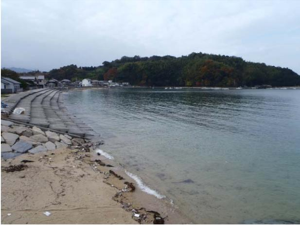
No.13：今治市玉川町中村）汀線勾配 1/15、底質は薄黄色の細砂。砂浜幅は約 5m。
