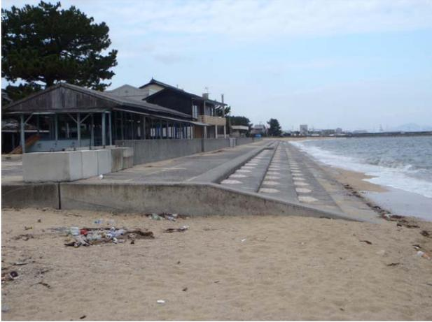
No.15: 前浜に建設された緩傾斜護岸の法先には波が直接作用している。
