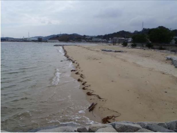
No.12：今治市大西星の浦）汀線勾配 1/20、底質は薄黄色の細砂。砂浜幅は約 20m。両端を突堤で囲まれた海岸。
