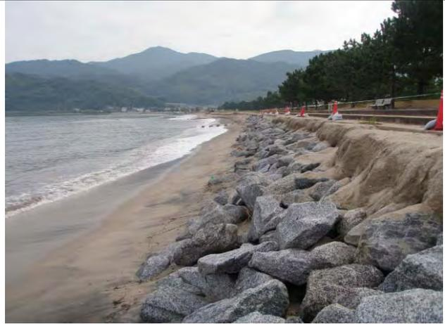
No.1 : 侵食は海岸護岸の基部近くまで達しており、養浜砂が消失して投入した石が露出していた。
