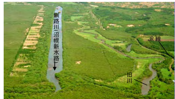
直線化した河道⑤ (旧川復元による再蛇行化を計画:国土交通省)
