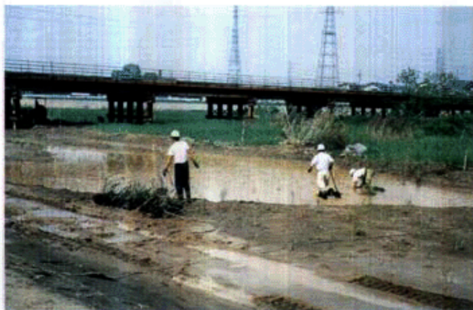
高水敷を既存のヨシ原と同じ高さまで掘削し、新たにヨシ原を造成している。
