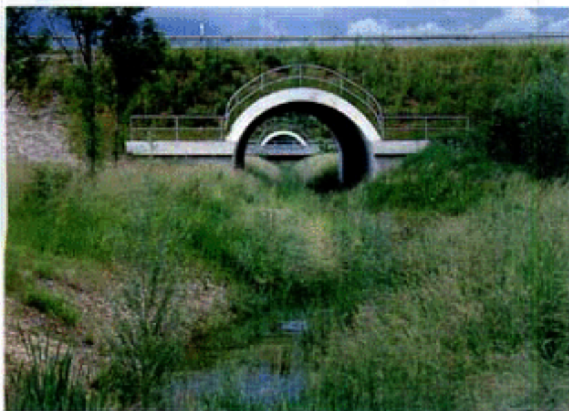
カエルなどのためのトンネル 高速道路によって小動物の移動路が分断されたため、トンネルをつくって移動路を確保している。
