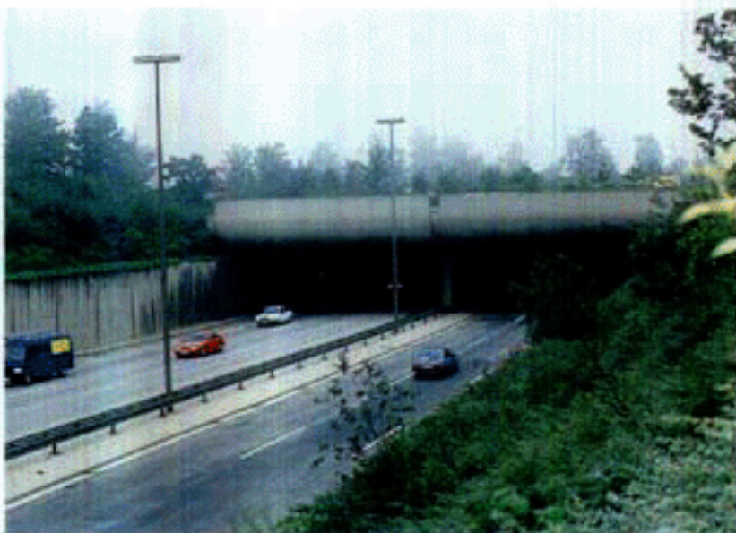
アウトバーンの蓋かけによる緑地の造成 デュッセルドルフ市の写真の例ではアウトバーンに蓋掛けをし、上部に表土を客土することで約9haの緑地を復元し、自然の連続性を取り戻している。
