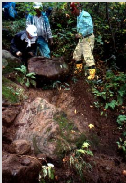
近自然工法を用いた登山道整備
