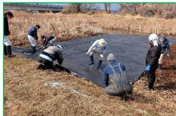
遮光シートの敷設：石組み護岸とヨシ混生地
