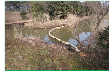
侵入防止フェンスの設置
