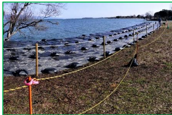
遮光シートの敷設：石組み護岸とヨシ混生地
