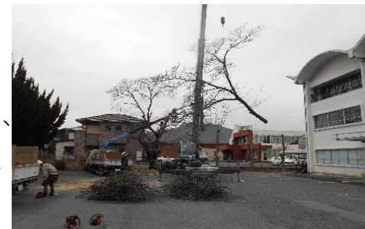
被害木伐採の様子
