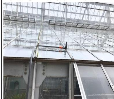
札幌でも夏を待たずに極端な高温が記録されることがあり、そのような年に数回の極端な高温にも対応ができるよう、昨年度に開発した冷却棚の機能・効果の強化が必要と判断された。そのため、本年度は、冷却棚にミスト装置の増設と屋根散水の追加を行い、その効果を検証する。
