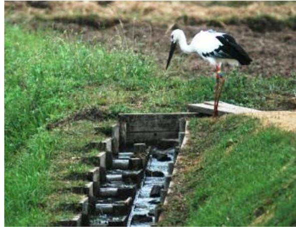
写真5. コウノトリの野生復帰の推進に向けた農地整備 水田に設置された魚道
