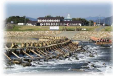
賑わい拠点の整備 (五ヶ瀬川／延岡市)
