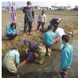
④集落総出で魚道を設置
