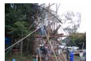
井戸掘り(上総掘り)
