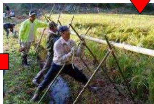
オタ棟組み立て(10月)
