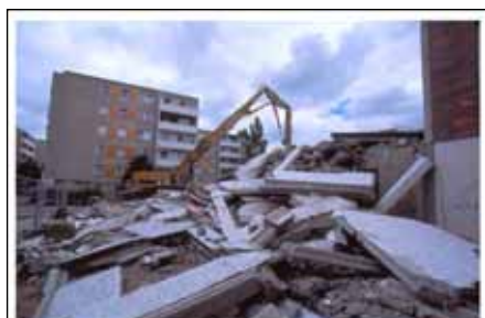
郊外部の建築物を撤去しているところ
