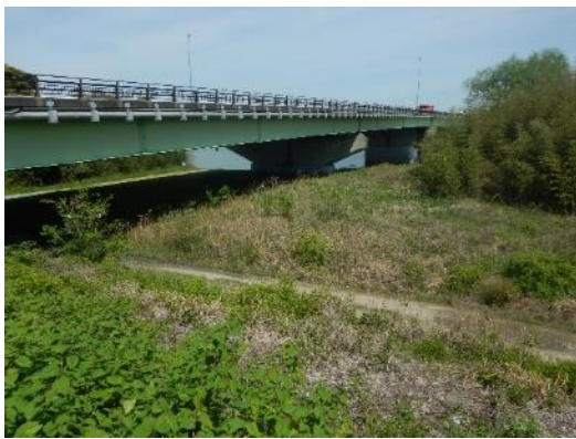
写真 22 雲出大橋と右岸側の河川敷
