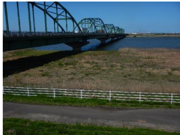
写真 7 小見川大橋の橋梁と右岸の河川敷
