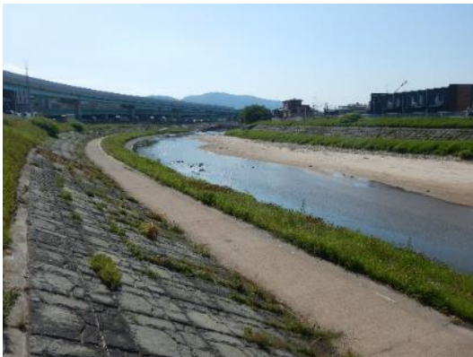
写真31 御笠川の河川敷（右岸側より撮影）
