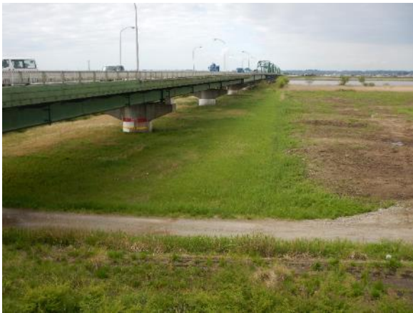
写真 6 小見川大橋の橋梁と左岸の河川敷
