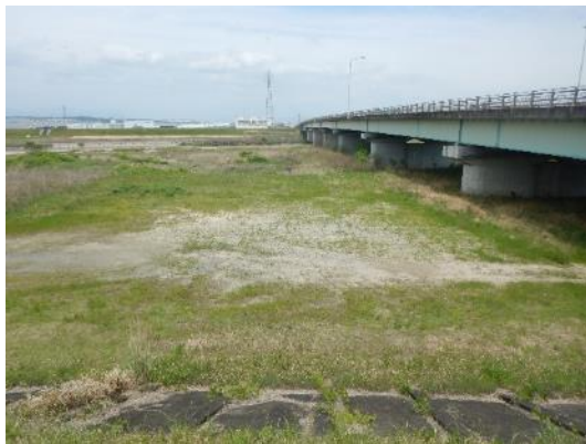
写真 18 鈴鹿大橋と右岸側の河川敷
