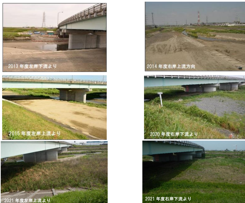
写真 17 平成 25 (2013) 年から令和 3 (2021) 年度にかけての 塩浜大橋付近 (内部川) の河川敷の土地整備・植生回復状況
