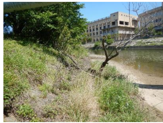
写真28 須恵川橋付近の右岸上流側の河川敷の低水敷
