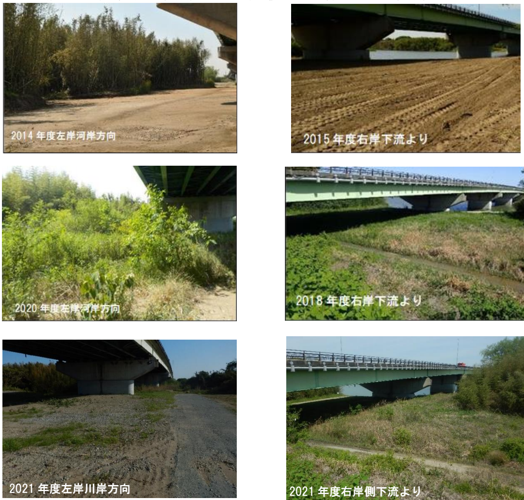
写真 26 雲出大橋（橋梁付近）の河川敷における土地整備・植生回復状況
