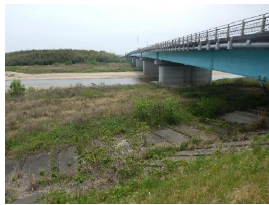
写真 19 鈴鹿大橋と左岸側の河川敷
