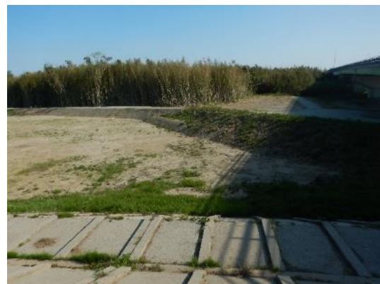
写真 23 雲出大橋と土地整備が実施された左岸側の河川敷
