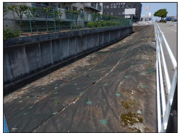
写真34 須恵川橋の道路沿い及び土手を覆う防草シート
