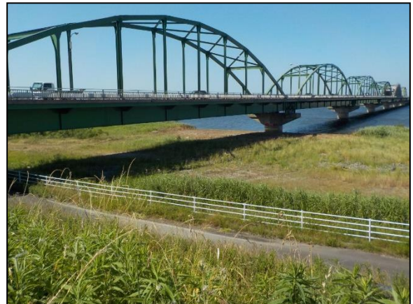
写真 7 小見川大橋の橋梁と右岸の河川敷
