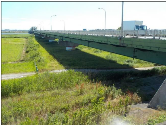
写真 6 小見川大橋の橋梁（左岸）
