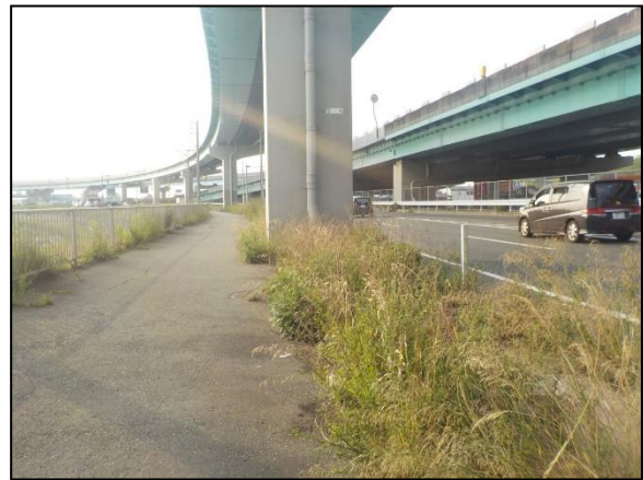
写真 38 国道3号線沿いの緩衝帯
