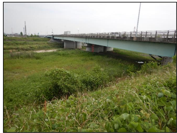
写真 16 内部川右岸の河川敷
