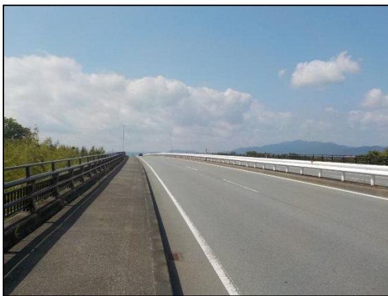
写真 27 国道 23 号線沿い及び雲出大橋
