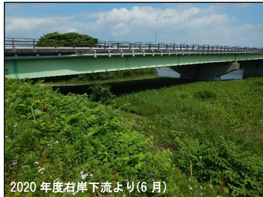
写真 32 平成 26(2014)年度から令和 2(2020)年度にかけての雲出大橋(右岸橋梁付近)の土地整備・植生回復状況
