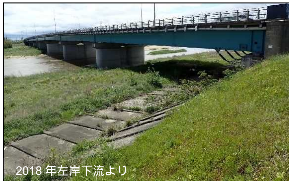
写真 26 平成 26(2014)年から平成 30(2018)年にかけての鈴鹿大橋(左岸橋梁付近)の土地整備・植生回復状況
