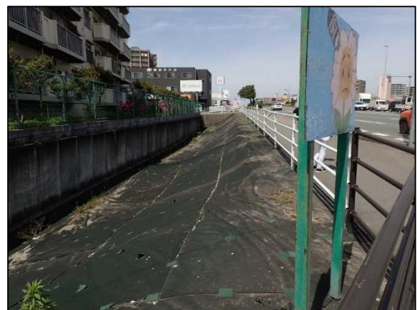
写真 36 須恵川橋の道路沿い及び土手を覆う防草シート
