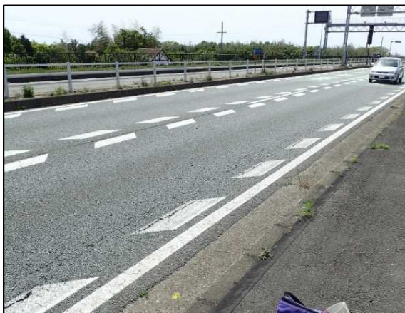
写真 28 国道 23 号線沿い及び雲出大橋
