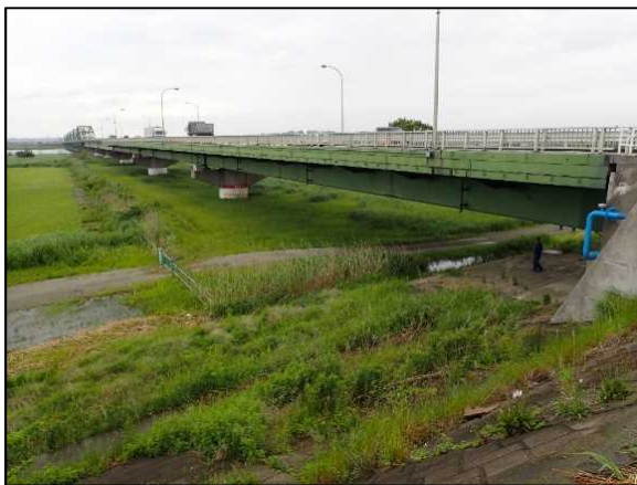
写真7 小見川大橋の橋梁(左岸)
