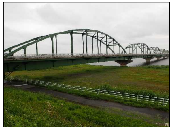
写真8 小見川大橋の橋梁と右岸の河川敷
