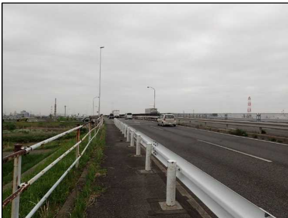
写真 16 塩浜大橋の橋梁上
