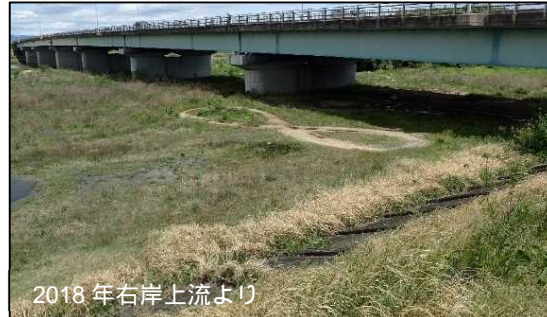
写真 27 平成 25(2013)年から平成 30年(2018)にかけての鈴鹿大橋(右岸橋梁付近)の土地整備・植生回復状況
