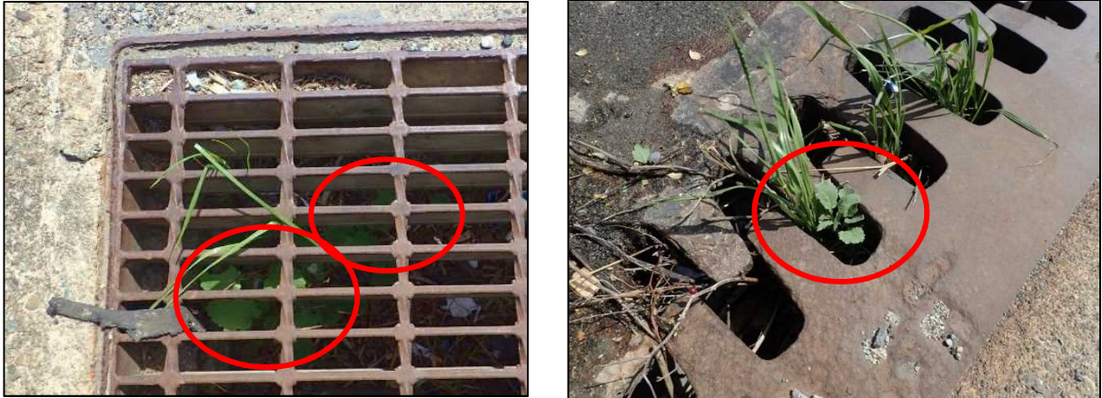
写真 30 雲出大橋の橋梁上の排水溝内等に生育するセイヨウナタネの実生
