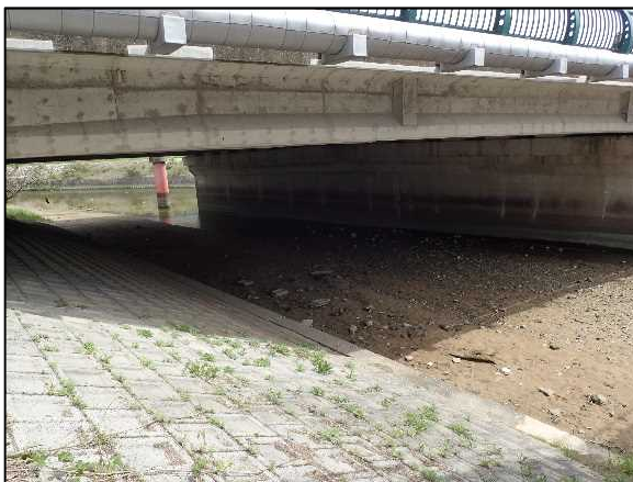
写真 35 須恵川右岸の橋梁周辺の河川敷
