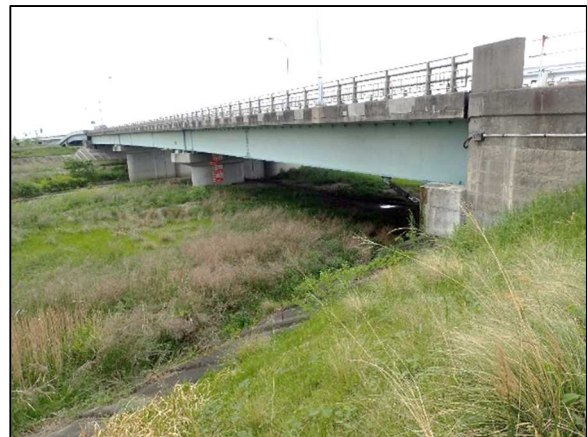
写真 17 内部川右岸の河川敷
