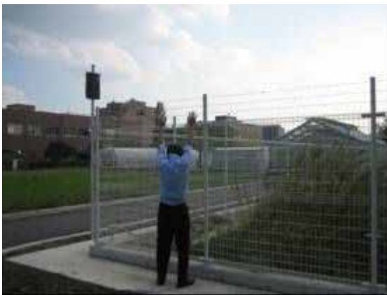
図 3 : 高さ 230cm のフェンス
