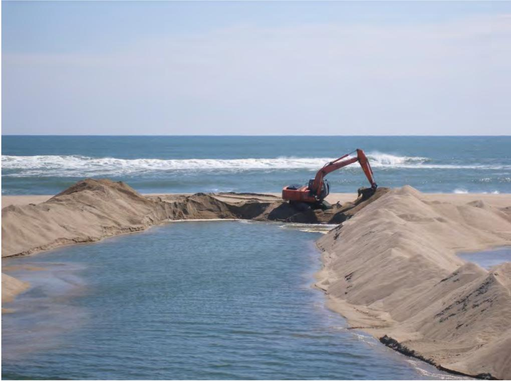
写真127. 河口閉塞による営巣環境悪化を改善するための開削作業
