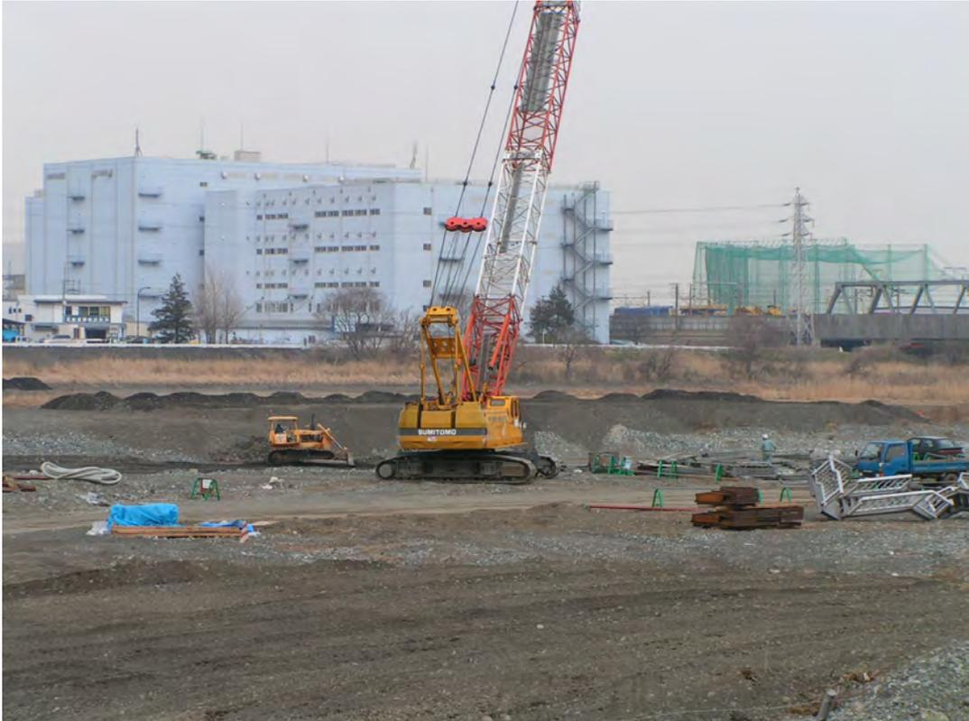
写真152. 小田原市による河川への高台の造成作業
