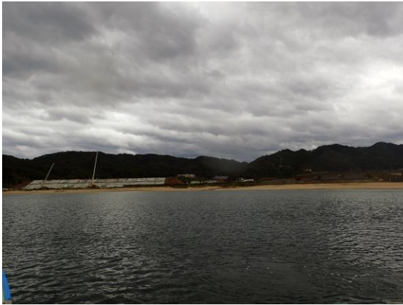
1 調査地景観(船越湾:吉里吉里エリア) 海側より陸側を望む。海岸での防潮堤の工事が進んでいる。
