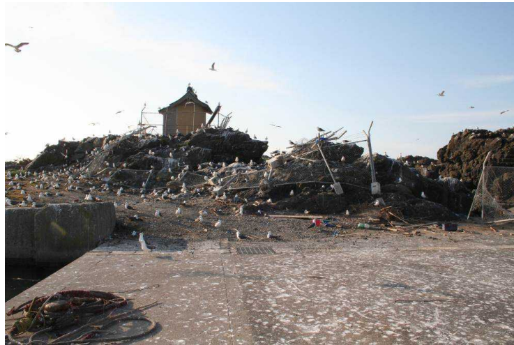
写真4-3-5 大久喜漁港内のウミネコ繁殖地、津波により金網フェンスがなぎ倒されている（2011年6月3日）
