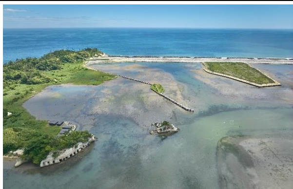
1 景観 (A エリア(鶴の尾)の全景) 遊歩道橋の手前がALポイント、奥部がAUポイント。遊歩道の護岸上にも多くの底生動物が付着していた。ドローンによる空撮。
