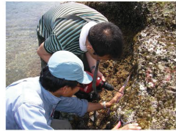
3. ハンマードリルで岩礁を穿孔する
