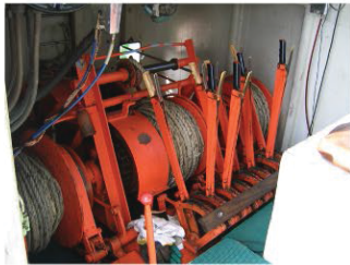
1. ウインチ (機材を上下運搬する)
