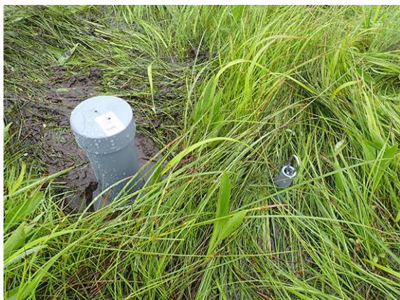
調査ラインの中央付近に設置した地下水位管
