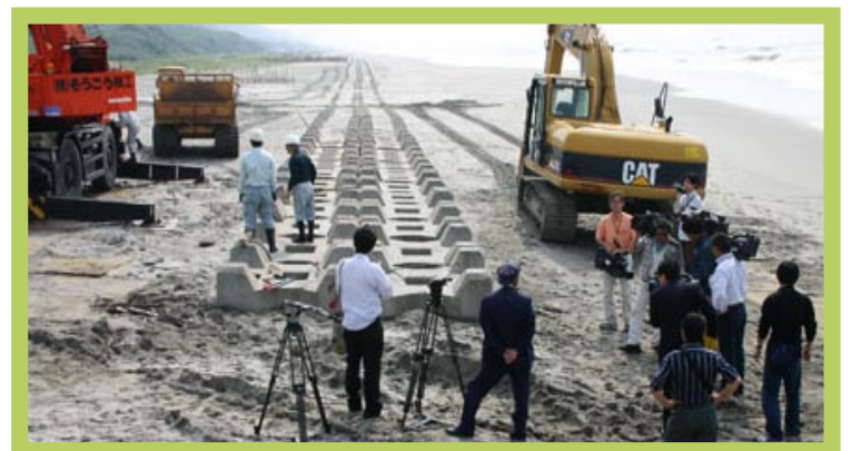
撤去される消波ブロック（撮影：表浜ネットワーク）
