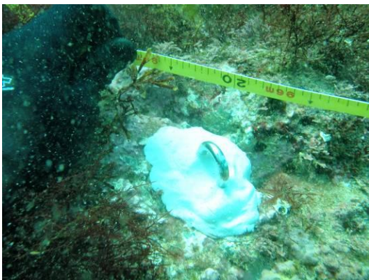
水中ポンドで海底に固定した金具（終点）
