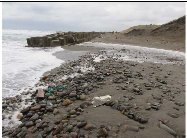
A5：つがる市冷水沼、汀線に波消工が設置。
