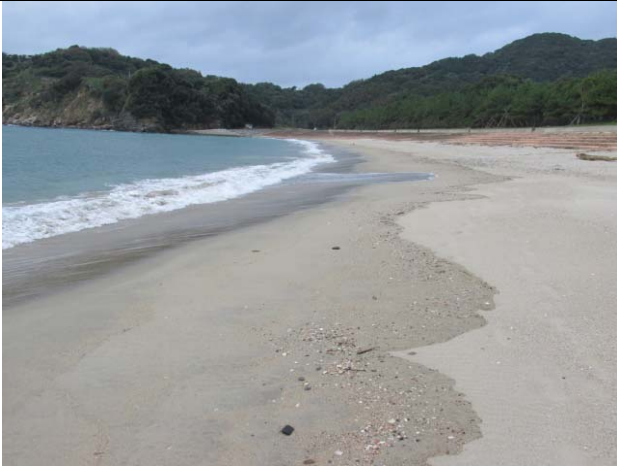
K13 : 天草市白鶴浜、下島西部。階段護岸一砂浜、汀線勾配 1/8、底質は薄黄色の細砂。
