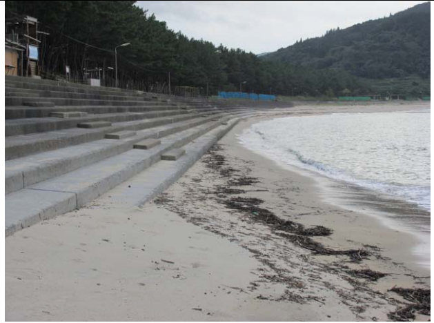
K13 : 天草市白鶴浜、下島西部。海岸は突堤を挟み南北に分離、南側は砂浜の発達が悪い。
