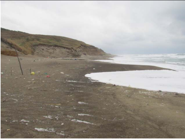
A7：つがる市高山稲荷神社前、無堤、崖が崩壊、砂浜幅 30m、汀線勾配 1/20、底質は灰色の中砂。
