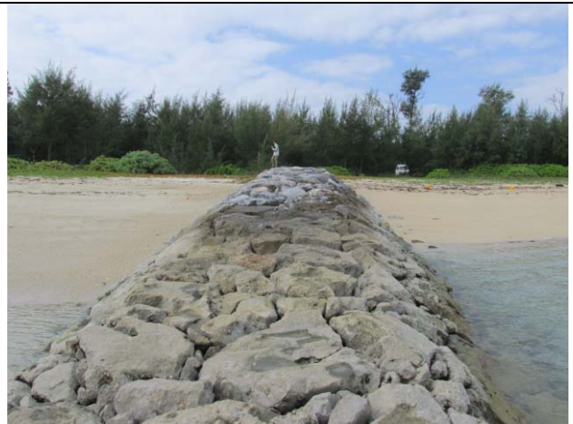
O22：突堤と離岸堤で囲まれている。
