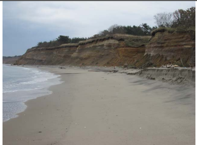
A20：東通村石持漁港東、無堤、高さ約 20m の崖が崩壊。
