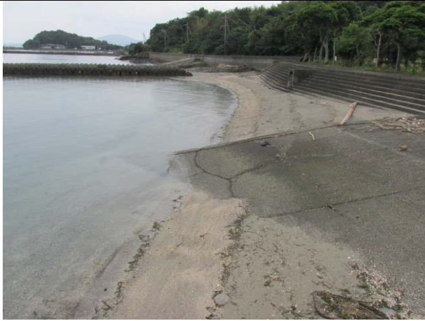
K9：天草市若宮、下島北部。階段護岸一砂浜、汀線勾配 1/10、底質は薄灰色の中砂。
