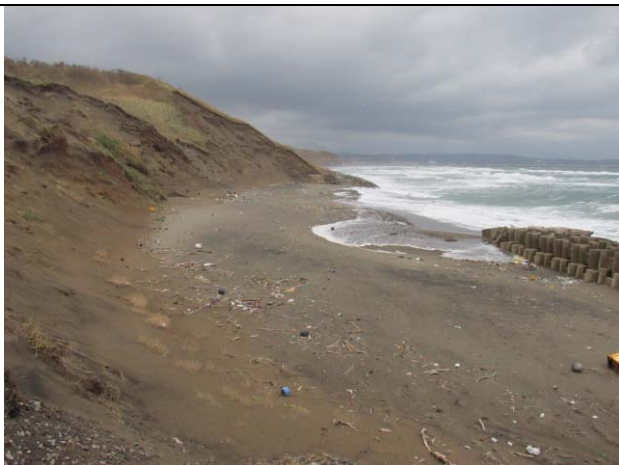
A5：つがる市冷水沼、無堤、崖が崩壊、汀線勾配 1/20、底質は灰色の中砂に礫混じる。
