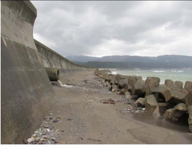
A1：深浦町柳田、汀線に波消工が設置され、背後は直立護岸、汀線勾配 1/15、底質は灰色の中砂。
