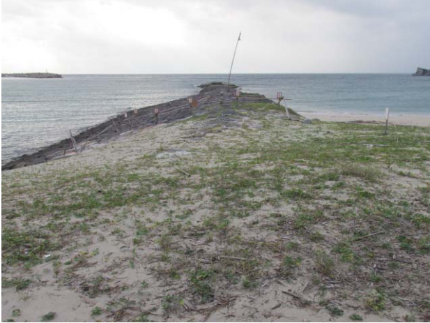
K13 : 天草市白鶴浜、下島西部。漂砂の向きは写真右から左（北から南）。
