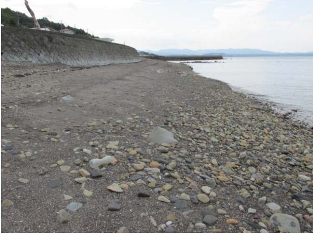
K7：天草市、上島北部。直立堤防－砂浜、汀線勾配 1/8、底質は礫混じり薄灰色の粗砂。
