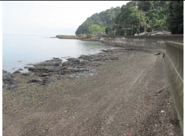
K16 : 芦北町上田浦。直立堤防一砂浜一干潟。汀線勾配 1/12、砂浜の底質は礫混じり灰色の中砂。
