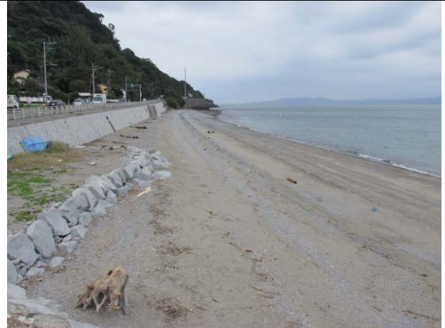
K5：宇城市大田尾、宇土半島北部。直立堤防－砂浜、汀線勾配 1/12、底質は薄黄色の粗砂。
