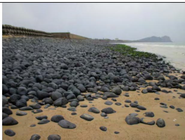
No.19 投入された玉石
