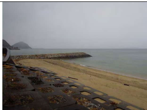
No.6 三豊市仁尾サンビーチ) 階段護岸、砂丘植生・海岸林なし
