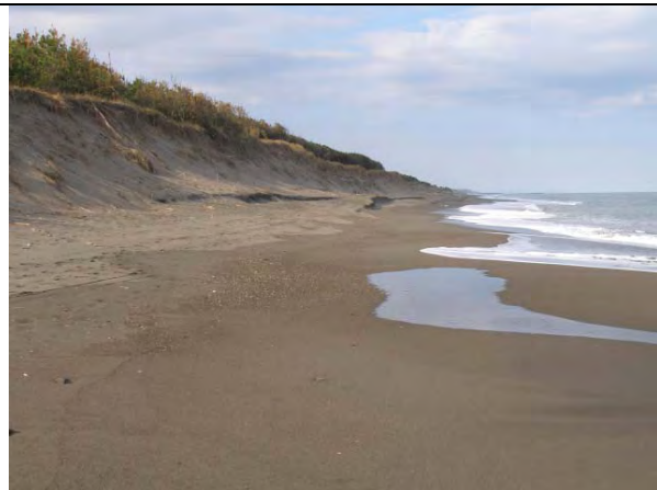
宮崎地区（住吉）：砂浜幅 30m、汀線勾配 1/25
