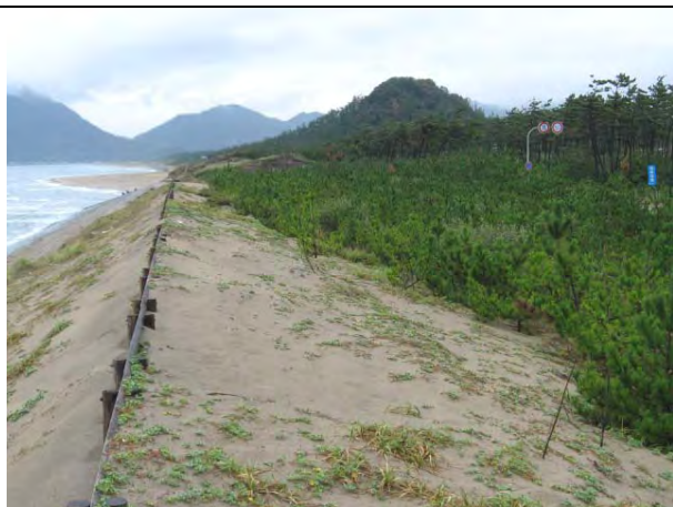
堆砂垣上部まで堆積した飛砂、クロマツ林
