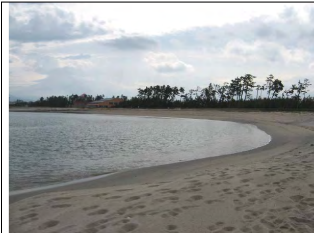
陸側へ大きく後退した離岸堤開口部の汀線
