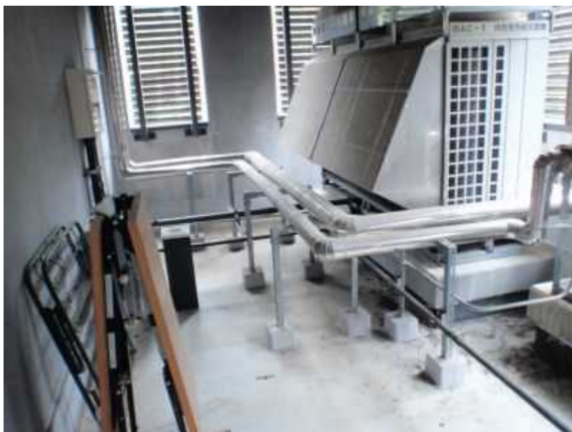
10 テラス床コンクリートの打ち直し及び防水、床面勾配の修正
