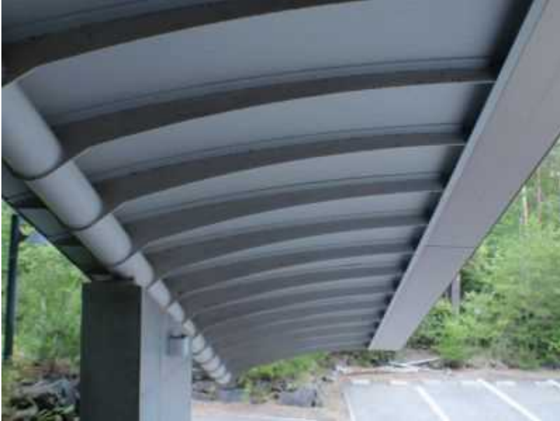
01 鉄部の再塗装①（職員入口階段屋根裏側）
