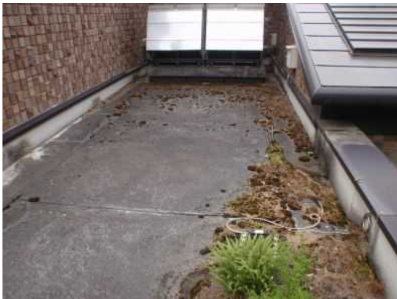
09 テラス床コンクリートの打ち直し及び防水
