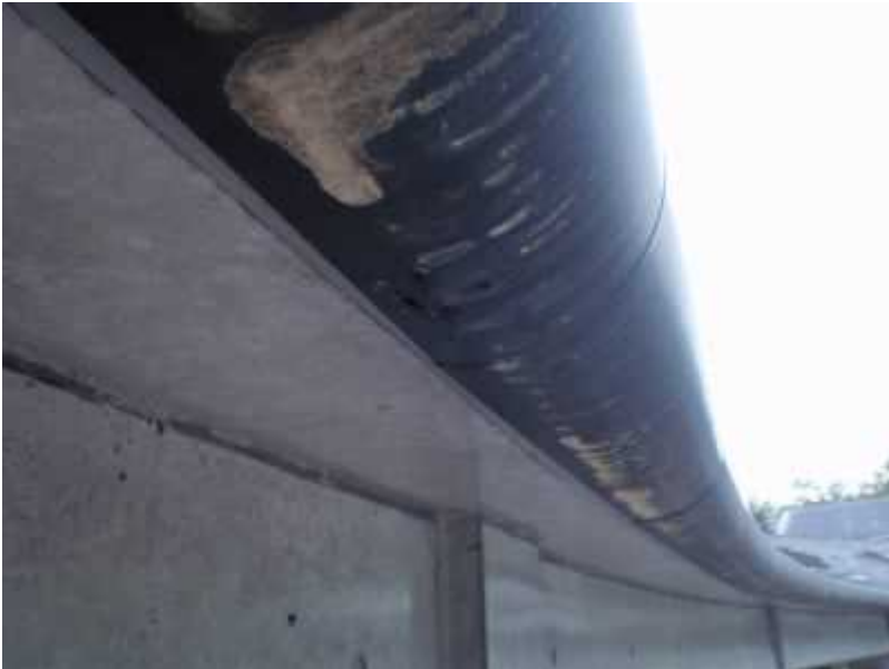
12 屋根庇部の腐朽
