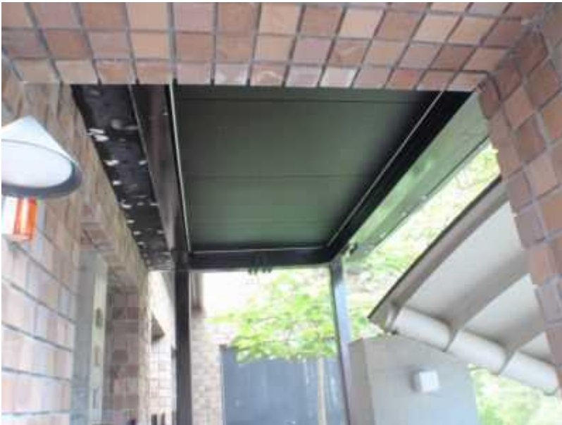
01 鉄部の再塗装②（職員入口階段屋根踊り場裏側）
