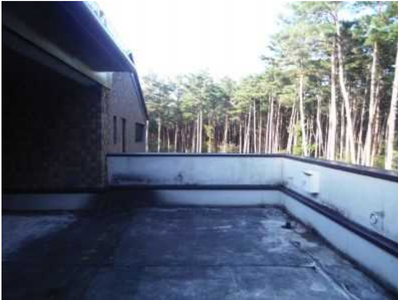
13 テラス転落防止柵に雪捨て用扉追加
