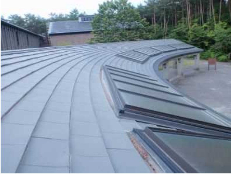
11 屋根採光ガラス周辺からの水漏れ
