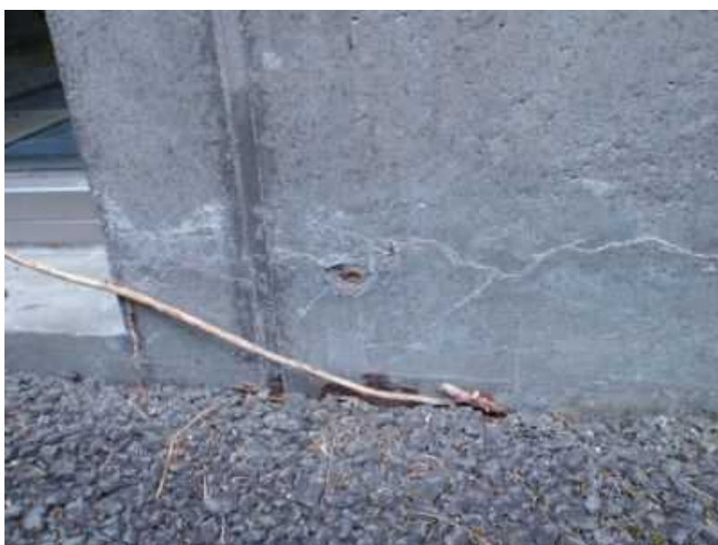
18 コンクリートクラック修繕
