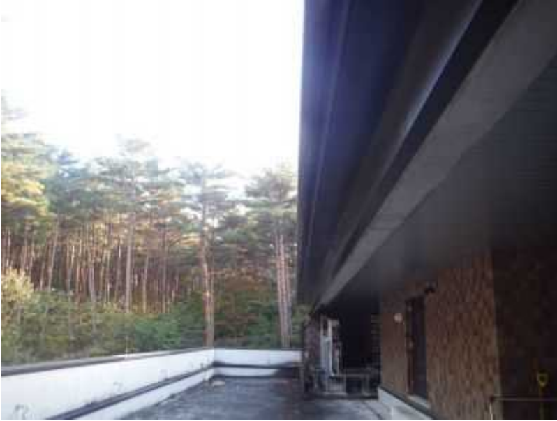
15 屋根底部の腐朽
