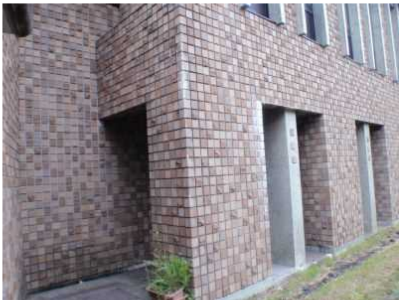
19 コンクリート水漏れ修繕
