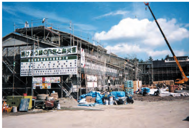
建設中のセンター(平成9年10月1日)
