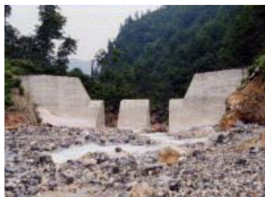
砂防えん堤のスリット化
