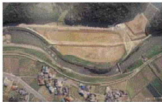
掘り下げた後のアザメの瀬（上部）（武雄河川事務所提供）
