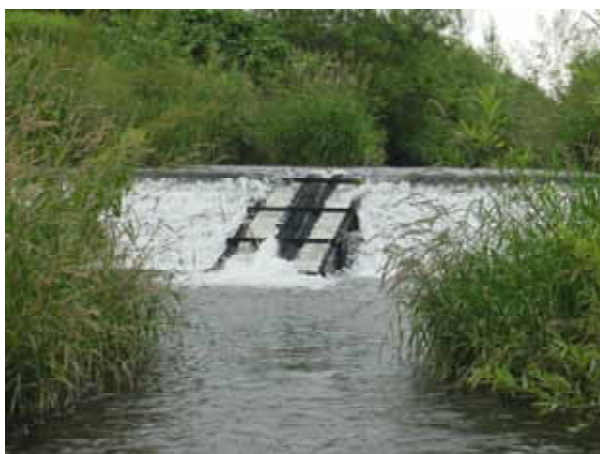
写真2 設置された魚道
