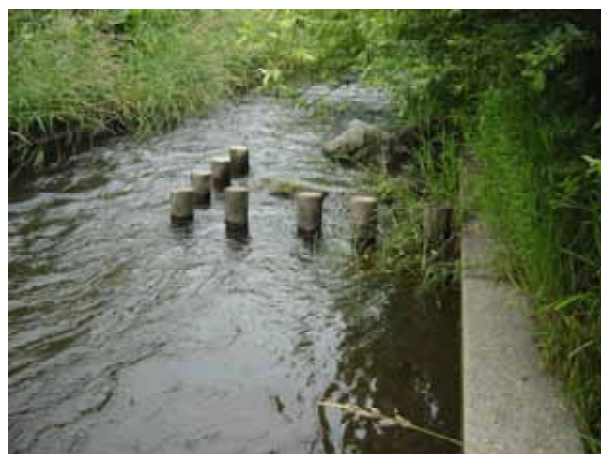
写真3 設置された水制
