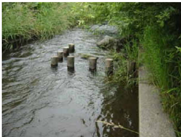
写真3 設置された水制
