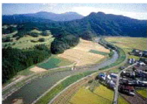
工事前のアザメの瀬（中央の農地）
